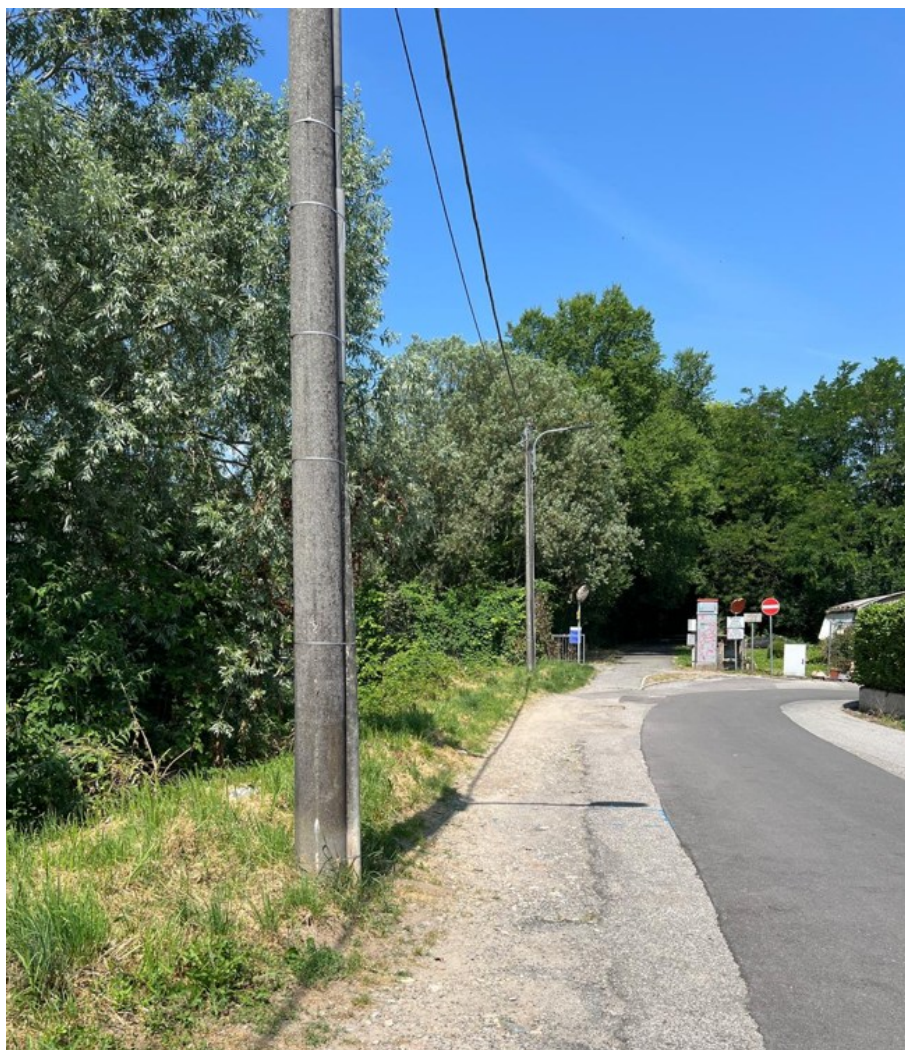
Figura 29 – pali di pubblica illuminazione e di sostegno linea elettrica
