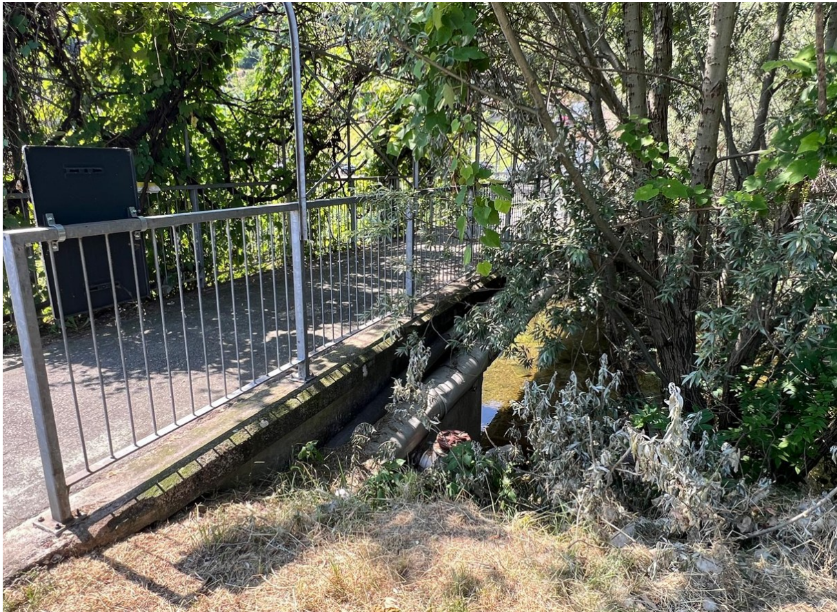
Figura 27 – tubazione acquedotto in corrispondenza della passerella pedonale
