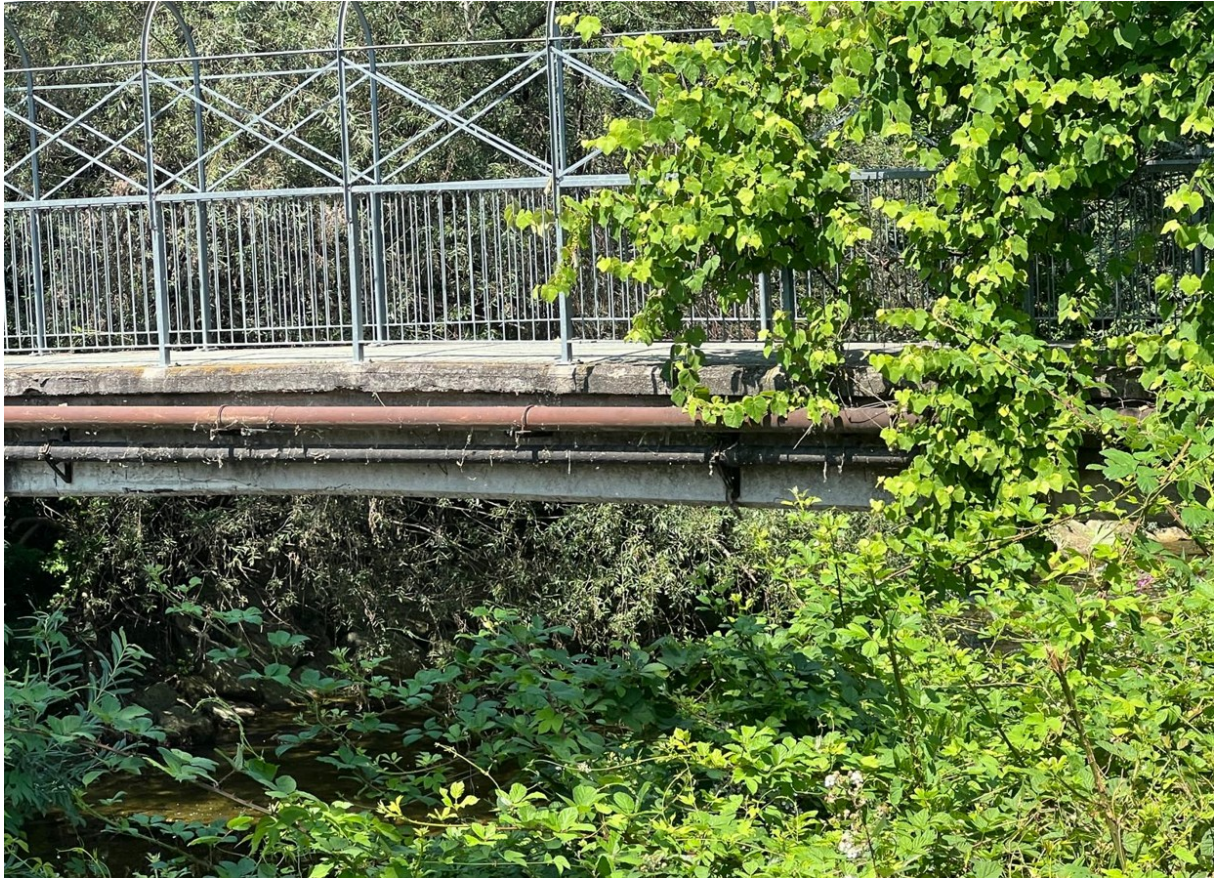
Figura 28 – tubazioni gas e linea elettrica in corrispondenza della passerella pedonale
