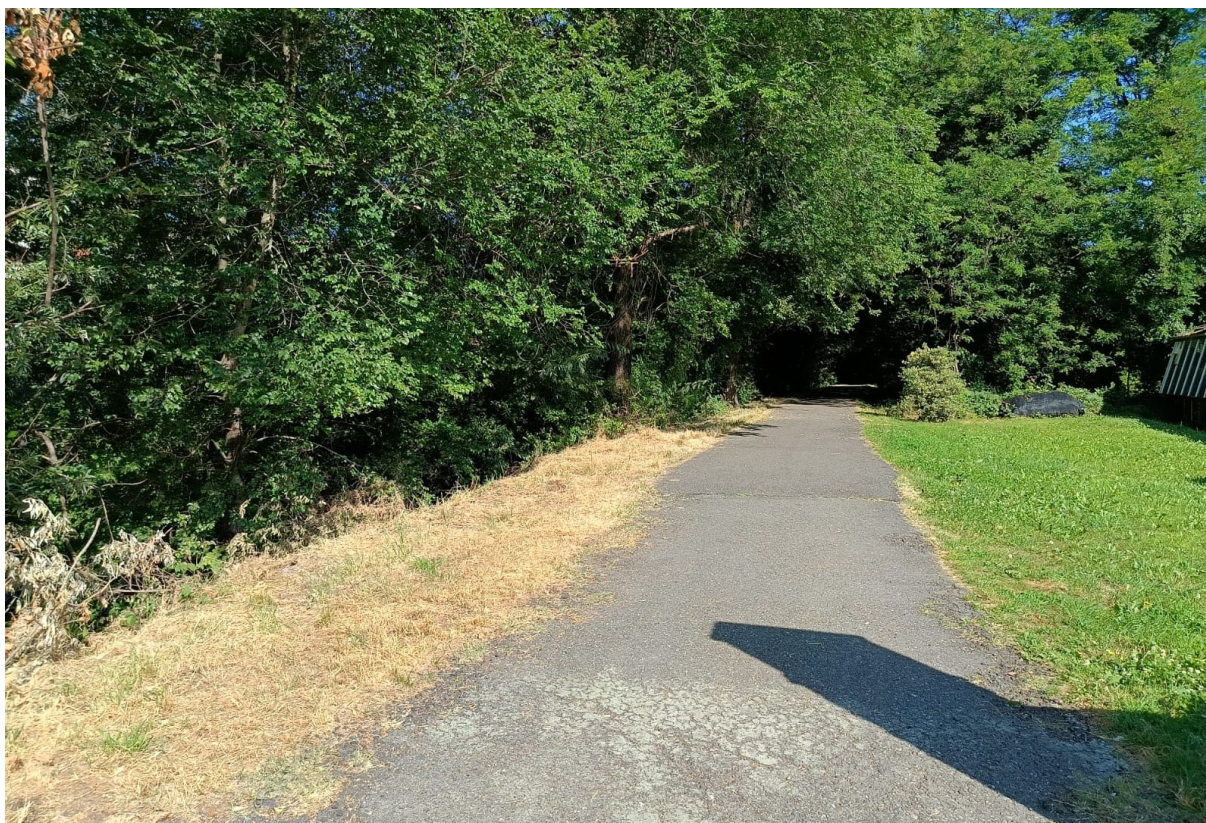
Figura 20: Stato di fatto dei luoghi, intervento tipo A - secondo tratto.
